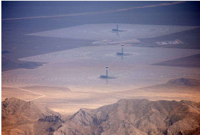
Slika 18 Solarna elektrana Ivanpah [26]
