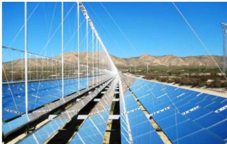
Slika 22 Fresnelovi kolektori integrirani u elektranu [23]
