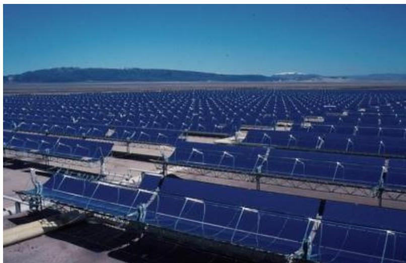
**Slika 31. Polje paraboličnih kolektora [26]**
