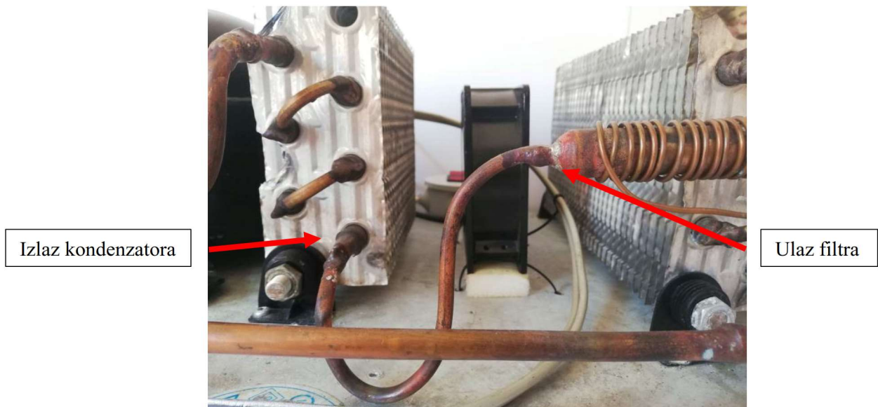
Slika 24. Povezivanje izlaza kondenzatora s ulazom filtra (sušača)
