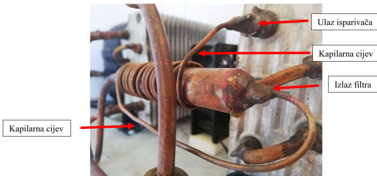
Slika 25. Povezivanje filtra i ulaza isparivača kapilarnom cijevi
