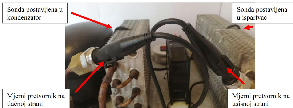
Slika 28. Postavljanje mjernih pretvornika i sondi
