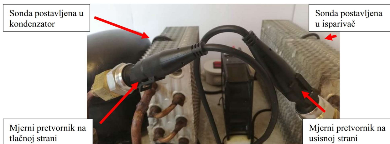
Slika 28. Postavljanje mjernih pretvornika i sondi
