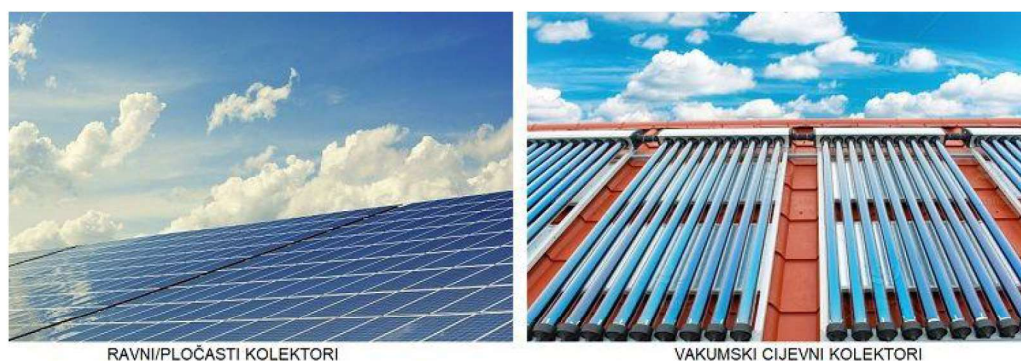
Slika 10 Pločasti i vakuumski solarni kolektori [14]
