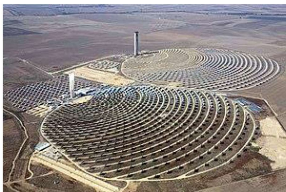
Slika 16 prikaz elektrane sa solarnim tornjevima u Sevilli[18]
