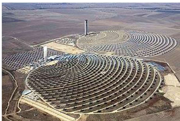
Slika 16 prikaz elektrane sa solarnim tornjevima u Sevilli[18]
