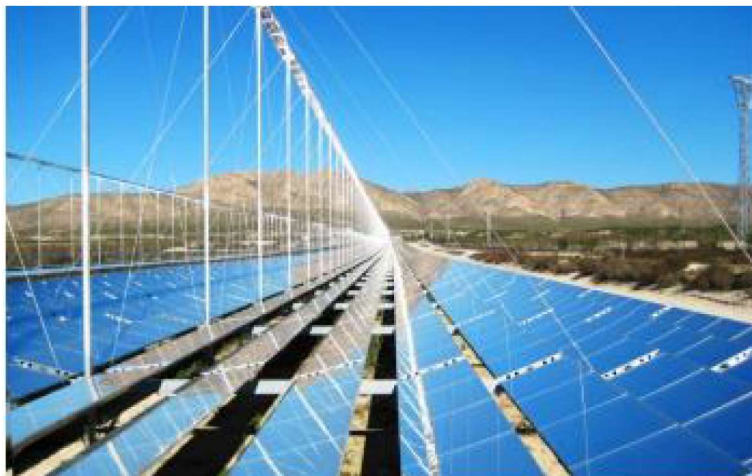
Slika 22 Fresnelovi kolektori integrirani u elektranu [23]
