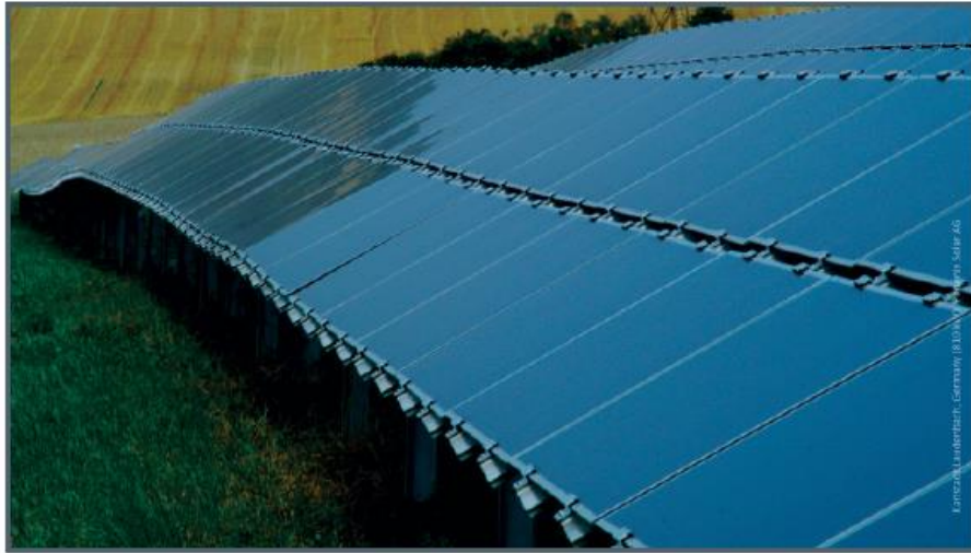
Slika 3. Energetsko postrojenje u ruralnoj Njemačkoj [2].
