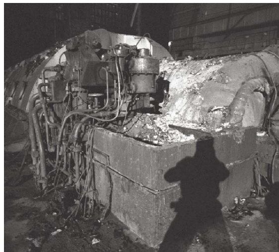
Slika 4: Uništena turbina [3].
