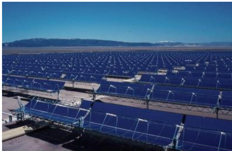
Slika 31. Polje paraboličnih kolektora [26]
